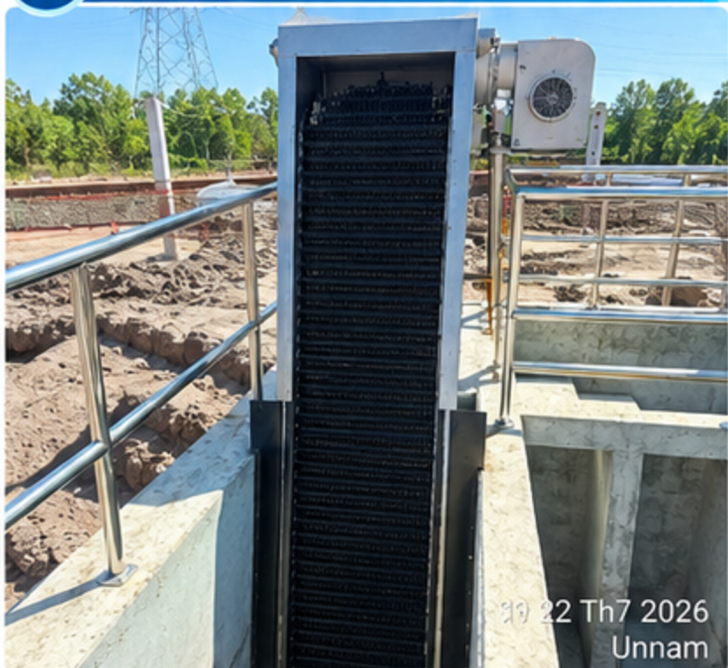
Máy lược rác lắp đặt thực tế tại kênh, sông, trạm bơm
