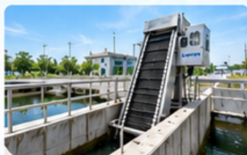
LẮP ĐẶT TẠI KÊNH, SÔNG
